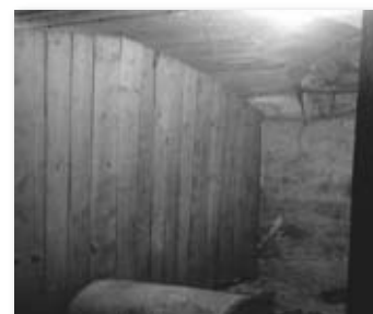
La cave avant les travaux
