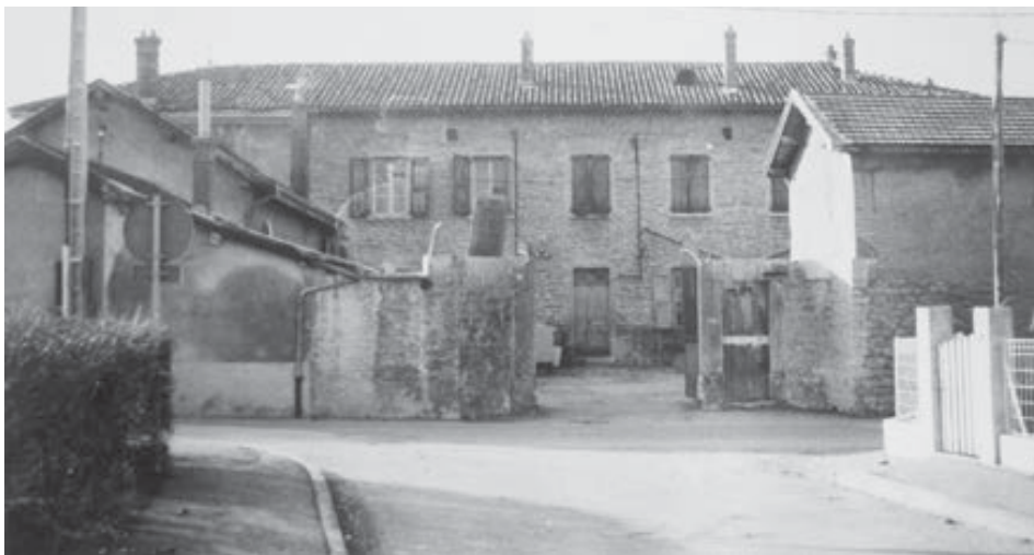
La première école de filles avant transformations de 1984
