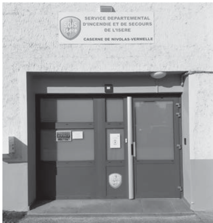
Porte d'entrée après travaux
