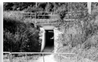
Passage piétons du km 44.001
