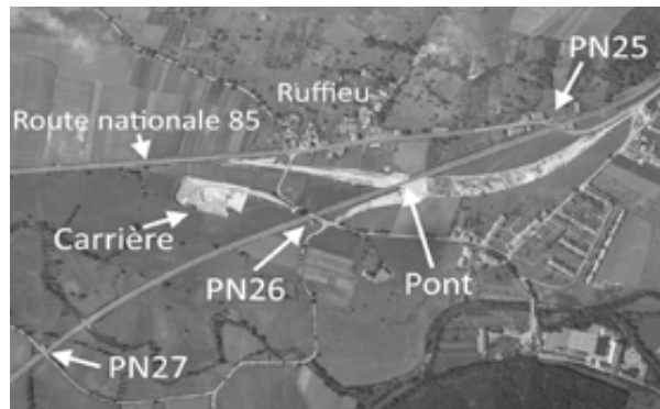
Vue du chantier en septembre 1945
