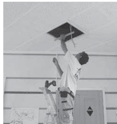
Changement des luminaires dans les classes
