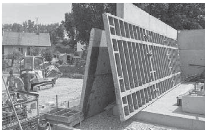
Le chantier de l'entrepôt communal
