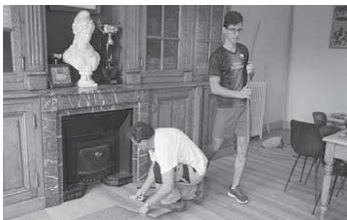
Rénovation salle des mariages
